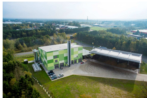
Abb. 11: Holzheizkraftwerk in Lathen
