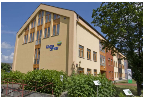
Abb. 14: Klimacenter in Werlte
