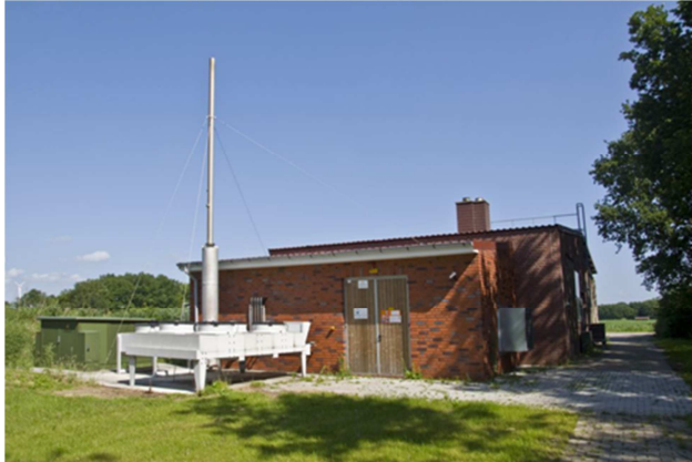
Abb. 10: Holzheizwerk in Vrees
